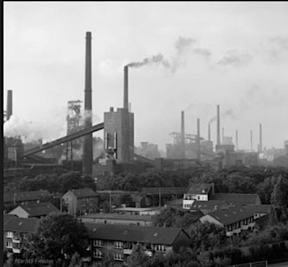
Aciéries et hauts-fourneaux de Bruckhausen à Duisburg (1991)
