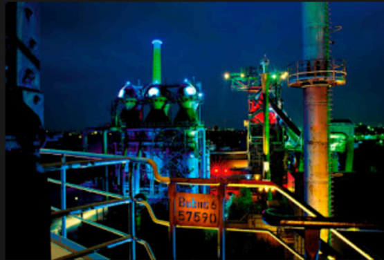
Mise en lumière de bâtiments industriels par l'architecte anglais Jonathan Park dans le Parc de Duisburg Nord
